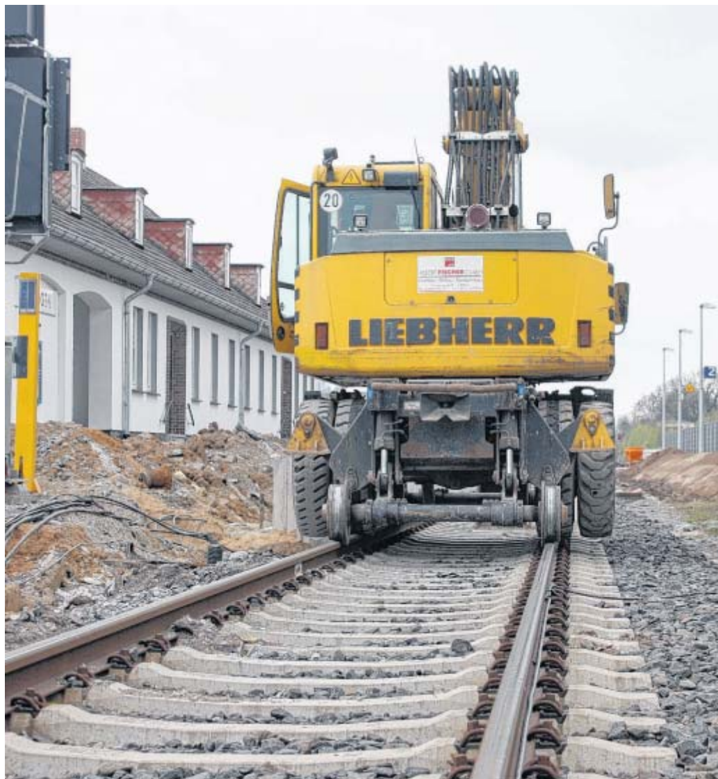
Mit dem Bagger auf den Gleisen: Die Erdarbeiten am Bahnhof Ottbergen laufen auf Hochtouren. Zudem entstehen an der Kreuzung zur Kochstraße eine Stützmauer und eine barrierefreie Bushaltestelle (Foto r., oben).
